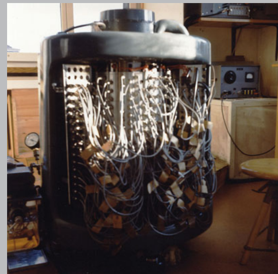
Der grosse Magnettrommelspeicher der Ermeth, dessen Bau Kopfzerbrechen bereitete, © Bildarchiv, ETH Zürich
