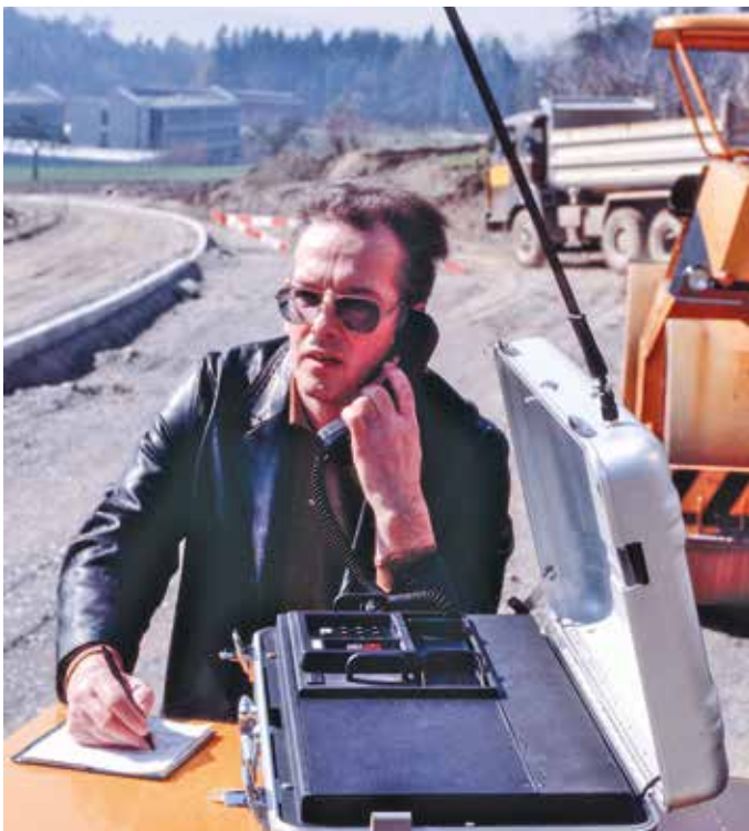
Bild 7: BBC «Natelport» auf der Baustelle ©ABB
