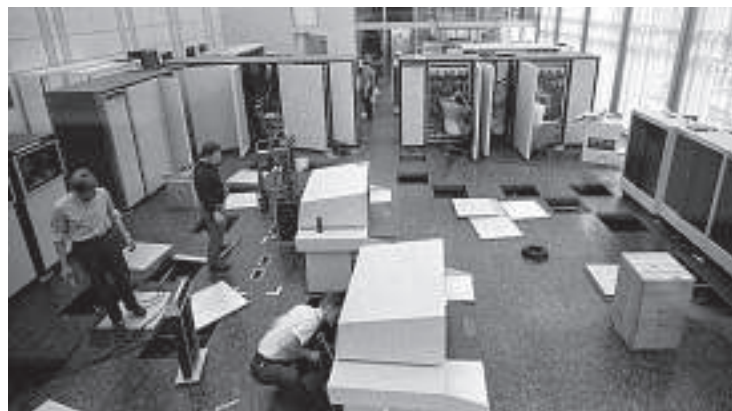
Die CDC 6400/6500 wird im neuen Rechenzentrum (RZ) an der Clausiusstrasse 55 installiert. Foto: ETH-Bibliothek
