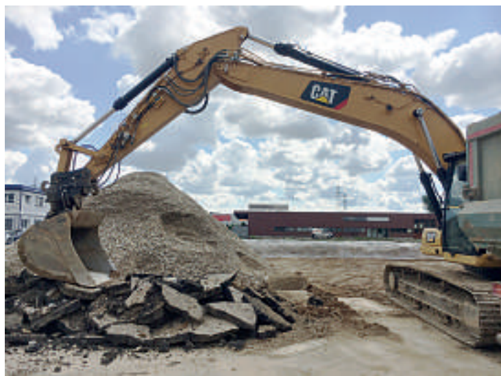
Baustelle Technikwelt ENTER: Die Aushubarbeiten sind abgeschlossen
