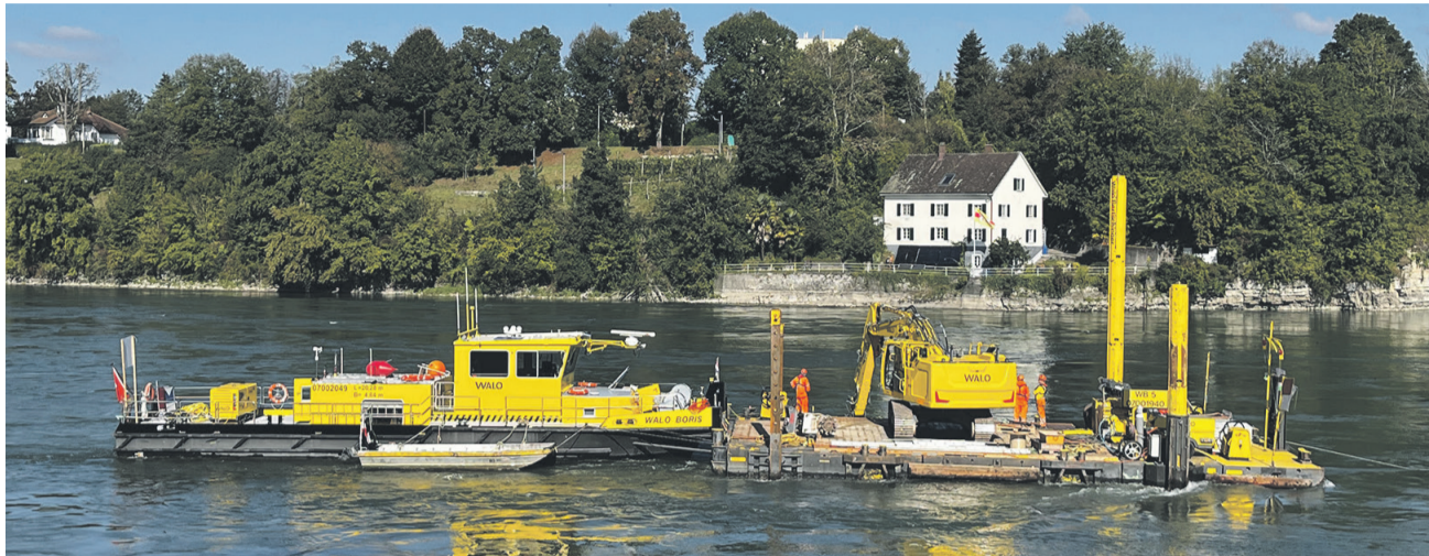
2024 ist ein Probeaushub zur Prüfung der technischen Machbarkeit und der Umweltverträglichkeit durchgeführt worden.
